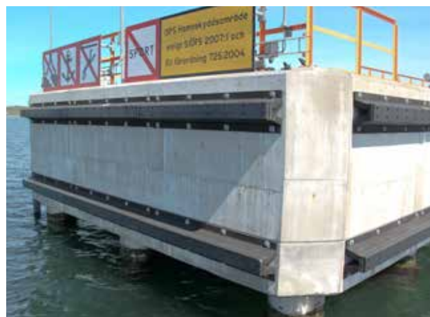
Ethanol Jetty | Stenungsund | Sweden
