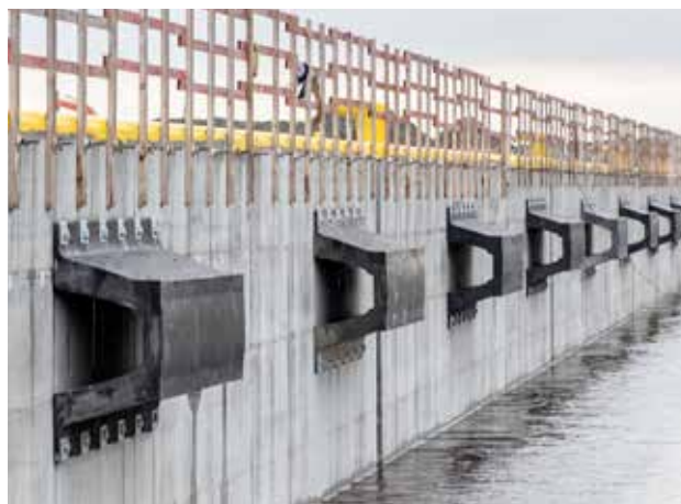
Boudewijnkanaal | Zeebrugge | Belgium
